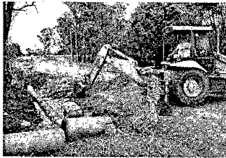
Com apoio de empresários, canos são colocados
