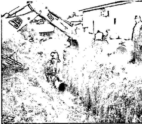
Novos canos e galerias em redes de esgoto
